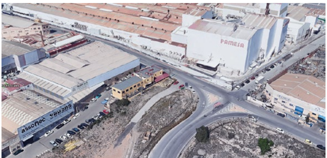
Figura 29. La mejora del estado de los viales y la construcción o ampliación de aceras es necesaria en polígonos como Ramonet
